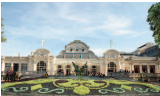
Façade du Palais des Congrès Opéra de Vichy
